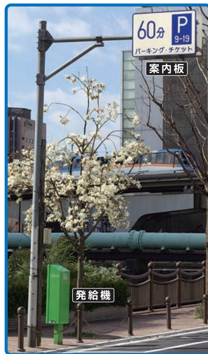
パーキング・チケット発給設備
